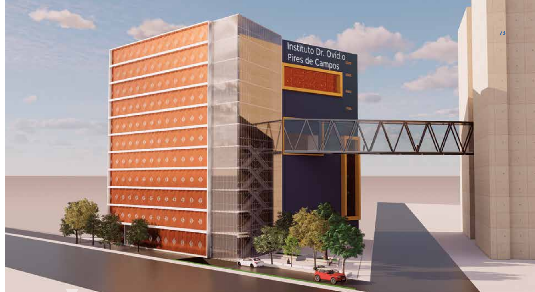
Perspectiva da fachada do novo Instituto Dr. Ovídio Pires de Campos, em construção.
